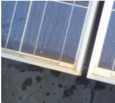
Bei Modulen, die mit weniger als 15° Neigung montiert sind, bildet sich leichter eine Schmutzschicht (braun-orange) am unteren Modulrand.
